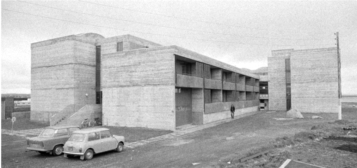
Mynd 24 Hjónagarðar 1978. Horft á húsið til suðurs, sem sýnir byggingarhæðirnar, tvær, þrjár og fjórar. Ytra byrði var á fyrstu árum hússins eins og sjá má á myndinni, ómáluð sjónsteypa. 80
