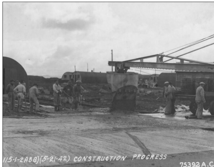
Mynd 65 Unnið við að steypa akstursbraut eða veg heim að verkstæðisbröggum 21. maí 1942. Í sumum tilfellum var notast við bómu til að dreifa steypunni úr steypuhrærivélinni. 193
