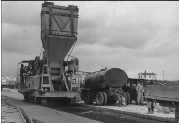
Mynd 64 Unnið við að steypa akstursbrautir og flughlöð. Beltasteypuvél lagði niður steypu, í eina hræru fór eitt hláss af sandi og sjö pokar af sementi, vatnstankur fylgdi með. Vélin lagði svo steypuna niður þegar blandan var tilbúin. 192
