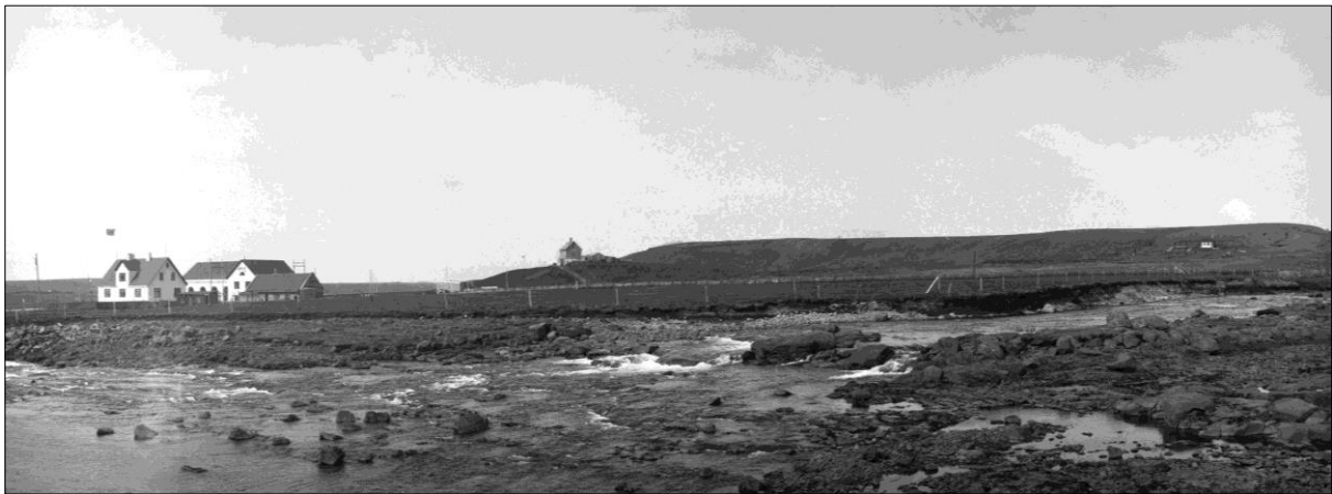
Mynd 19 Byggingar Rafstöðvarinnar við Elliðaár á ljósmynd frá um 1921-1925. Fremst sjást íbúðarhús rafstöðvarstjóra og fjós- og smiðjubygging en aftan við glittir í rafstöðvarhúsið. Fyrir miðri mynd er íbúðarhús Ártúnsbýlisins sem reist var árið 1910 og í fjarska lengst til hægri sést sumarbústaður, líklega bústaður sem Axel Meinhold, danskur kaupmaður, byggði á Ártúnsbletti 1 á þriðja áratugnum. 80
