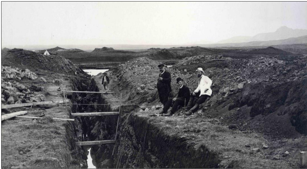
Mynd 17 Lagning vatnsveitunnar 1908 eða 1909. Yfirverkfræðingur framkvæmdanna, H.A. Hansen, stendur við skurðinn, en við hlið hans situr Knud Zimsen, þáverandi bæjarverkfræðingur Reykjavíkur. Í baksýn sjást Rauðhólar. 73
