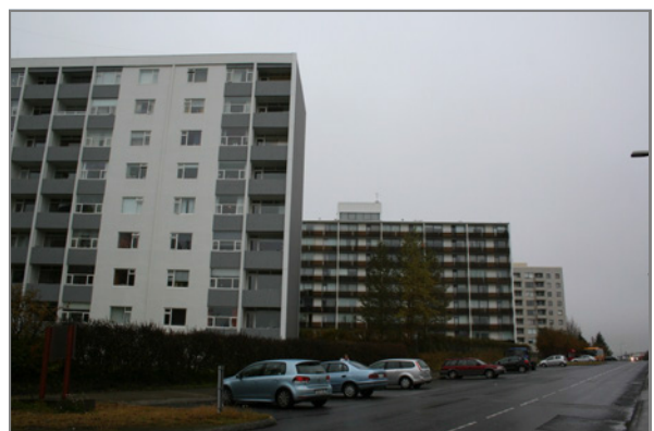
Mórernísk fjölbýlishús við Ljósheima árið 2012. MsR.
