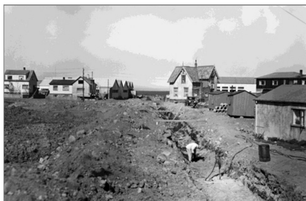
Framkvæmdir við lagningu holræsis og vegar þar sem Laugalækurinn lá áður, á ljósmynd frá um 1955. Ljós. Borgarskipulag. LsR.
