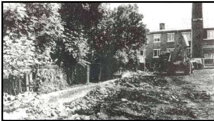
Framkvæmdir við niðurrif veggjarins í porti verkamannabústaðanna árið 1985. 21
