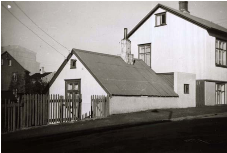
Steinbærinn Stakkahlíð sem stóð þar sem nú er húsið nr. 32 við Bræðraborgarstíg. Við hliðina má sjá gaflinn á timburhúsinu nr. 32a, sem stendur enn. 12
