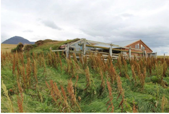
Jörð: Syðri-Brekkur (8:3) Hlutverk: Fjánhús Byggingarár: Fyrir 1920 Flokkur: Torfhús Hnit ISN93: 482174, 572101 Ljósmynd: Bryndís Zoëga, 2021
