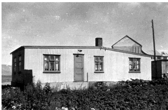
Húsið Sjáraborg, sem nú hefur verið rífið. 13
