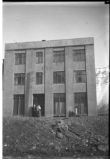
Húsið 1933-34 Ljósmyndasafnið Ísafirði
