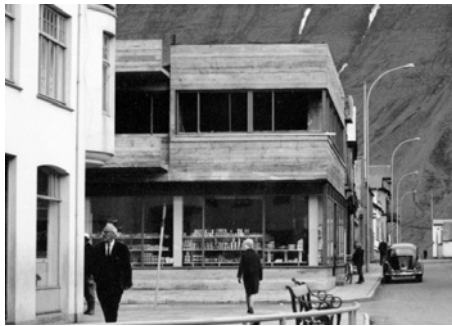
Húsið í byggingu árið 1965, mynd. JAB.
