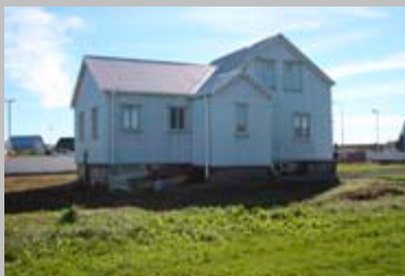
Strandgata 1 Bjarnaborg Byggt 1900
