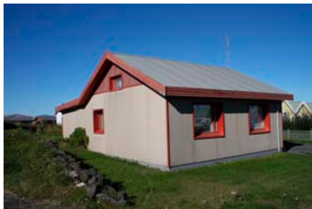
Garðbær byggt árið 1939 úr holsteini, síðar var steipt utan á vegg og þeir loks klæddir steniþlötum.
