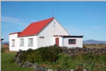
Ólafsvellir 2 Merkigarður Byggt 1902
