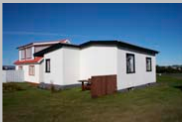
Eyrarbraut 45 Unhóll Byggt 1898
