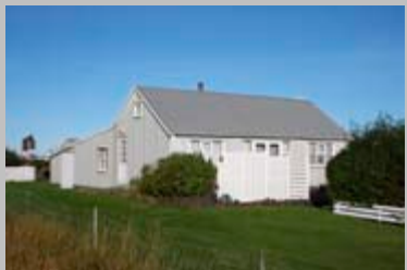
Heiðarbrún 14 Eystri-Bræðraborg Byggt 1899
