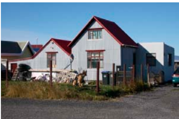
Hausthús við Eyrarbraut 17, elsti hluti hússins t.v. er frá 1896 en burstin t.h. byggð 1936.
