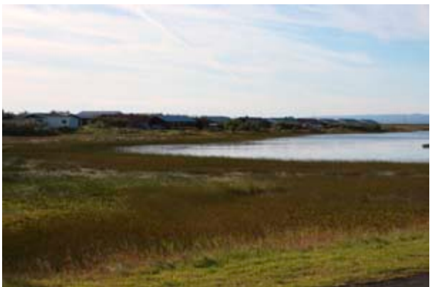
Viðlagasjóðshúsin á milli Eyrarbrautar og Löngudælar séð vestur yfir dælina. Húsin eru öll mjög svipuð hvað varðar form og efnisval og mikilvægt er að þessi húsafyrping haldi sérkennum sínum í þorpsmyndinni.
