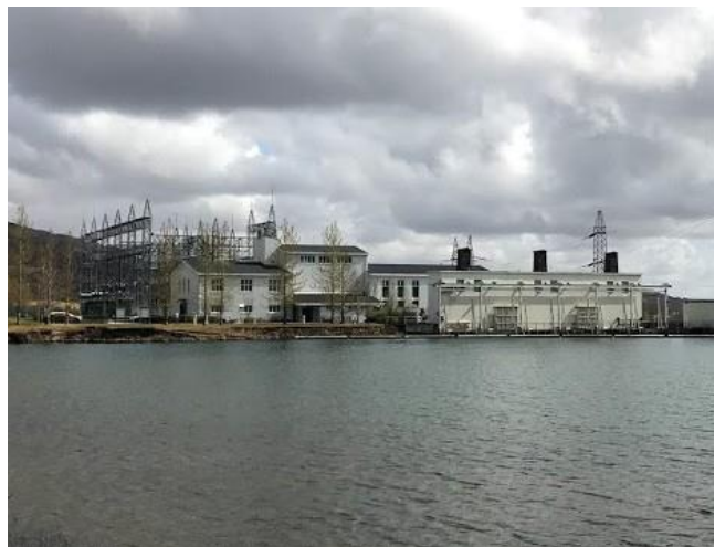
Yfirlitsmynd yfir Írafossstöð, 2018.
