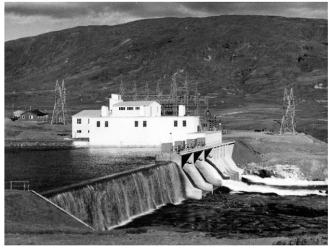
Séð yfir stíflu, lokustíflu og stöðvarhús. Mynd úr ljósmyndasafni Landsvirkjunar. Ártal óþekkt.
