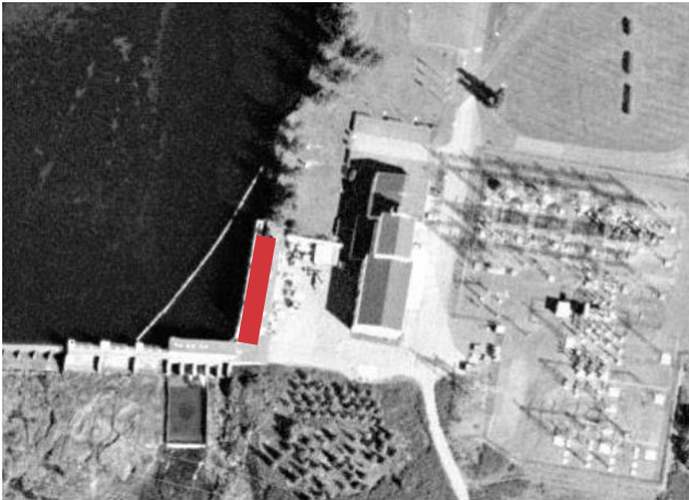
Hönnun: Sigurður Guðmundsson, arkitekt Fyrsti eigandi: Rafmagnsveita Reykjavíkur
