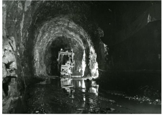
Gangnamannvirki á framkvæmdatíma. Mynd úr ljósmyndasafni Landsvirkjunar. Ártal óþekkt.
