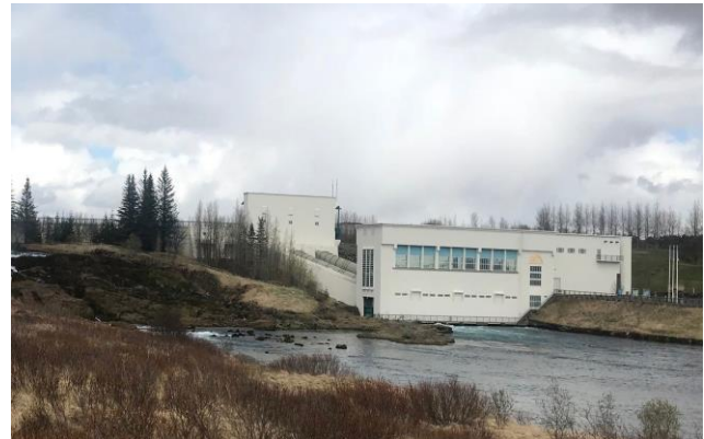
Upphafleg notkun: Stöðvarhús virkjunar Núverandi notkun: Stöðvarhús virkjunar
