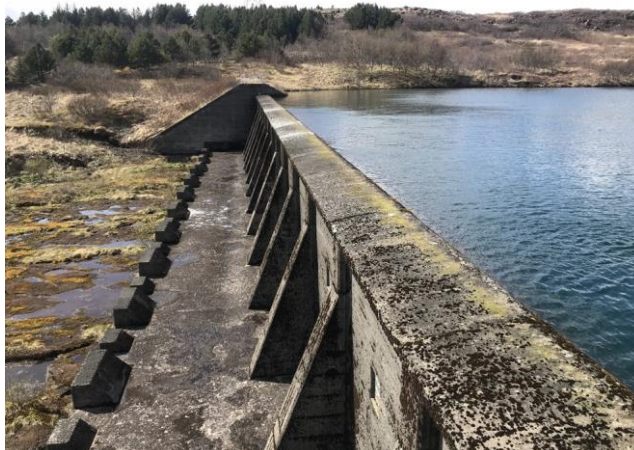
Upphafleg notkun: Stífla Núverandi notkun: Stífla
