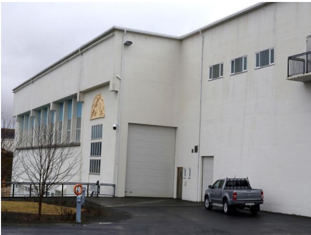
Stöðvarhús úr suðaustri, 2018.
