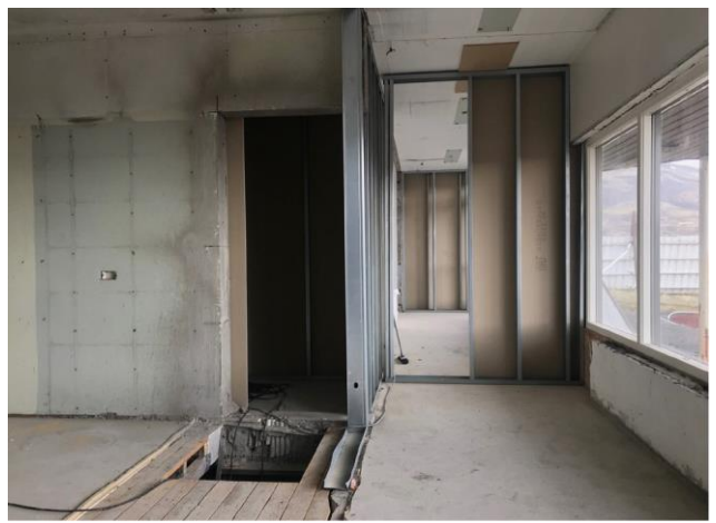
Ljósmynd innan úr húsi, 2018.
