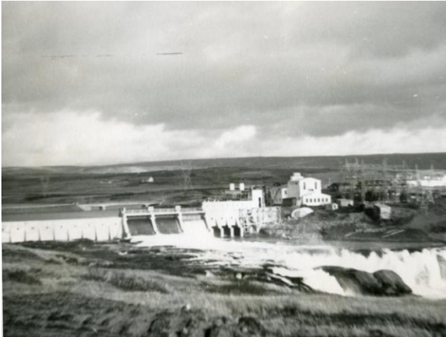
Horft yfir stöðvarsvæðið. Mynd úr ljósmyndasafni Landsvirkjunar. Ártal óþekkt.
