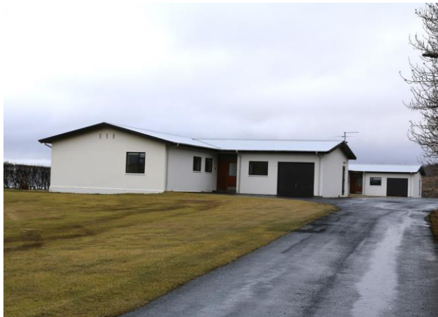
Upphafleg notkun: Starfsmannaíbúð Núverandi notkun: Orlofsíbúð
