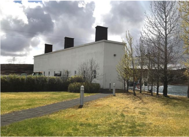
Inntakshús úr norðaustri, 2018.
