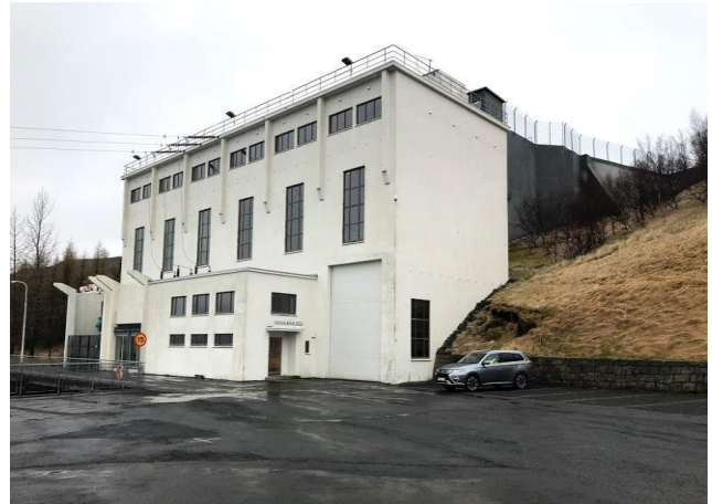
Upphafleg notkun: Stöðvarhús Núverandi notkun: Stöðvarhús
