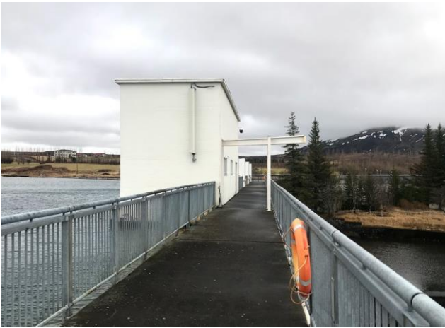
Lokuhús, horft úr vestri, 2018.
