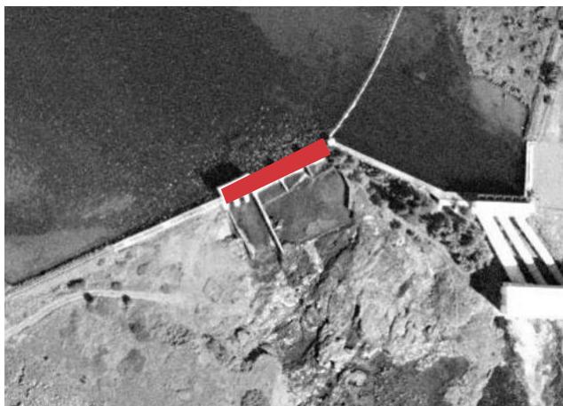
Hönnun: Sigurður Guðmundsson, arkitekt Fyrsti eigandi: Rafmagnsveita Reykjavíkur
