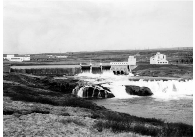
Horft norður yfir Írafossstöð, inntakshús er milli stíflu og stöðvarhúss. Mynd úr ljósmyndasafni Landsvirkjunar. Ártal óþekkt.
