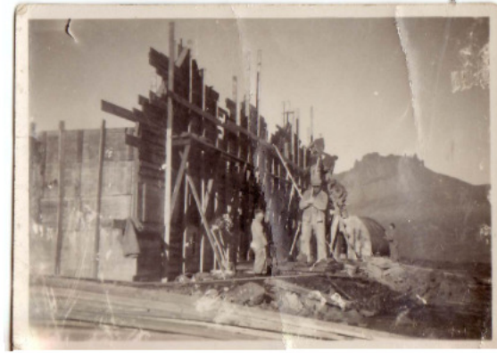
Slegið upp fyrir húsinu
