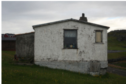
Austurhlið og norðurgæfl - núverandi ástand
