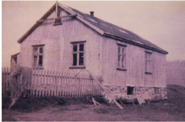
Húsið í upprunalegri mynd
