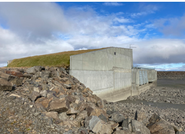
Inntakshús, horft úr vestri, 2020.
