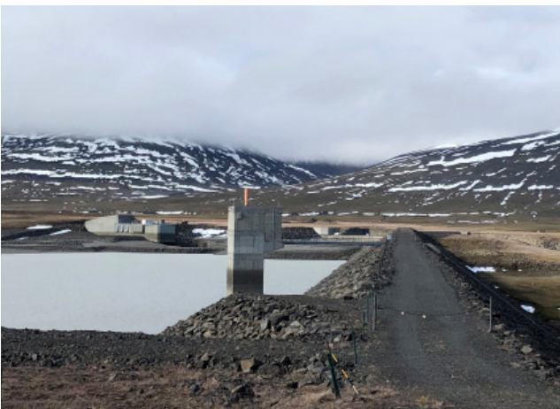
Hjólalokuhús, stífla og inntaksmannvirki, 2020.
