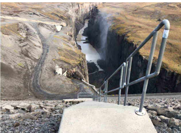
Horft niður með grjótveggnum, 2020.
