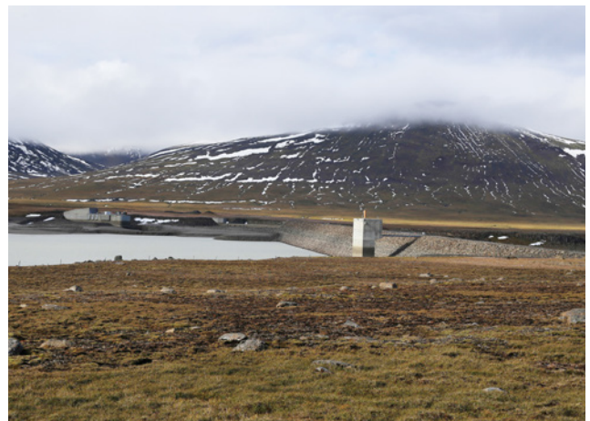
Hjólalokuhús, stífla og inntaksmannvirki, 2020.
