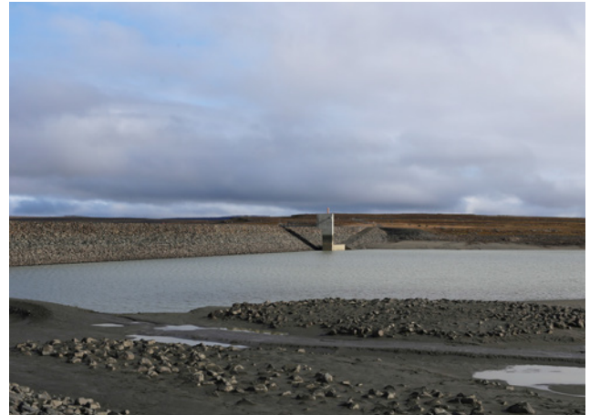
Hjólalokuhús, horft frá inntakshúsi Ufsarlóns.
