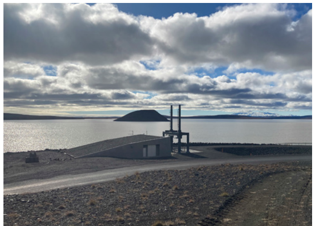
Horft suður yfir inntakslokuhús, Háslón í baksýn.
