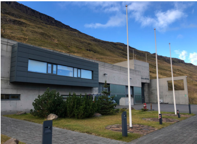
Hlaðhús, horft úr suðri. Hluti suðurhlíðar er klæddur sléttri klæðningu úr áli í dökkgráum lit, 2020.
