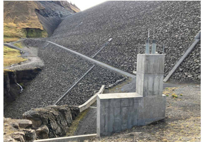
Horft yfir turn aðganga, Kárahnjúkastífla í bakgrunni, 2020.
