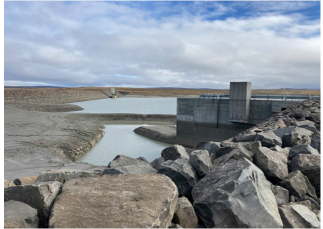
Inntaksmannvirki til hægri í bakgrunni til vinstri Ufsarlón og hjólalokuhús, 2020.
