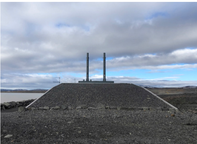
Horft vestur yfir inntakslokuhús, 2020.
