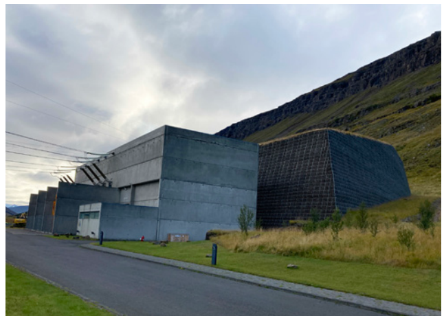
Tengivirki og snjóflóðavarnargarður, horft úr norðri, 2020.
