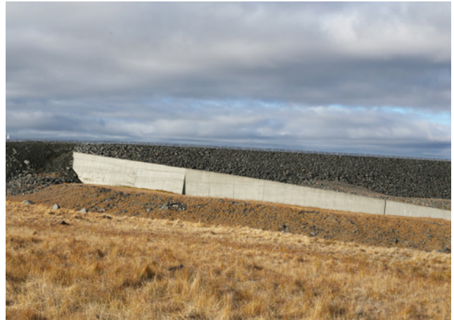
Steinsteyptur veggur sem er hluti af flóðavari stíflunnar, 2020.
