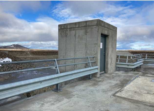
Hluti af inntaksmannvirki, 2020.
