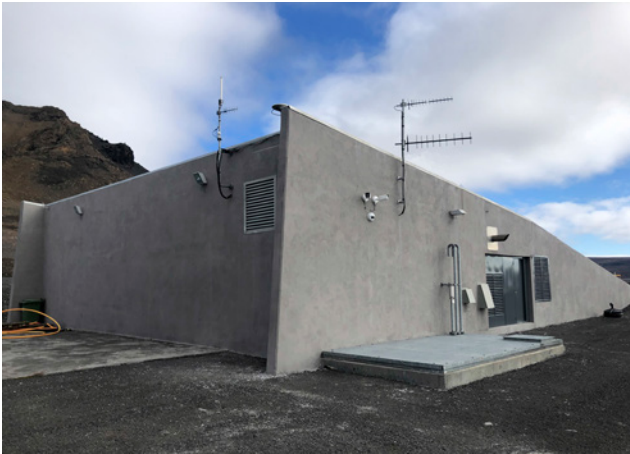
Inntakslokuhús, horft í norðaustur, 2020.
