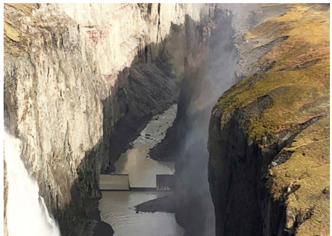
Fyrir miðju gljúfri sést steypur veggur sem var reistur til að mynda laug til að vernda gljúfurbotninn fyrir rofi, 2020.
