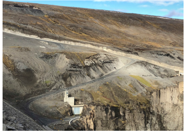
Aðgöng Kárahnjúkastíflu, yfirfallsrenna dregur línu í landslagið í bakgrunni, 2020.
