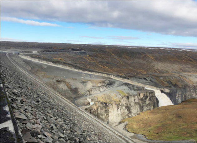
Horft frá Kárahnjúkastíflu yfir yfirfallsrennuna og gljúfurbarminn, 2020.
