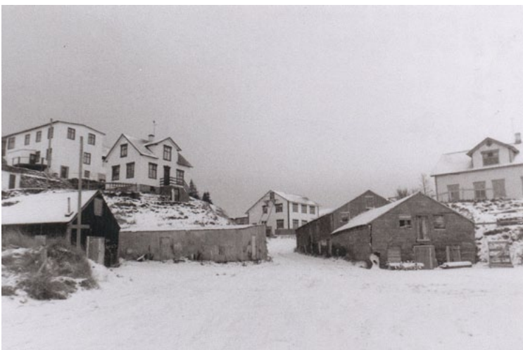
Séð upp Naustagil á Húsavík. Fiskverkunarhús Páls Kristjánssonar kaupmanns næst t.h. Til vinstri eru línuskúrar. Ofar frá vinstri: Hliðskjálfr, Móberg, Pálshús, Formannshús. Ljósmyndari: Víkurblaðið. Ljósmyndir í eigu Ljósmyndasafns Þingeyinga.
