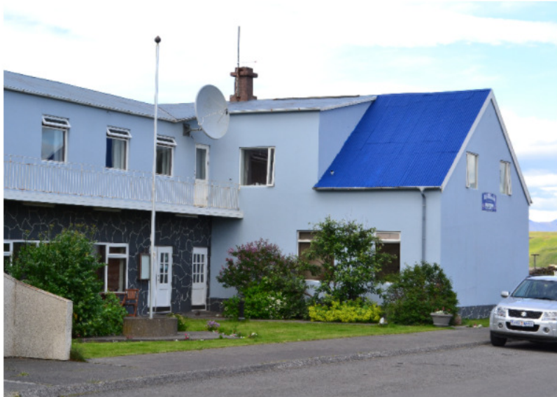
Elsti hluti hússins t.h. - Aðalinnangangur í viðbygginguna frá Aðalgötu
