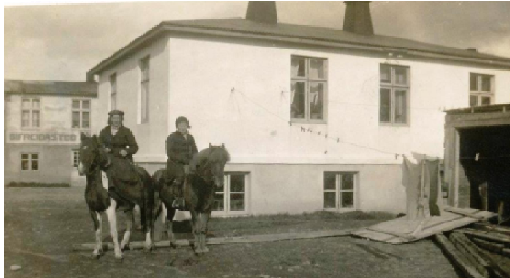
Hér sést á bakhlið húss og skúr í byggingu t.h. (áo)
