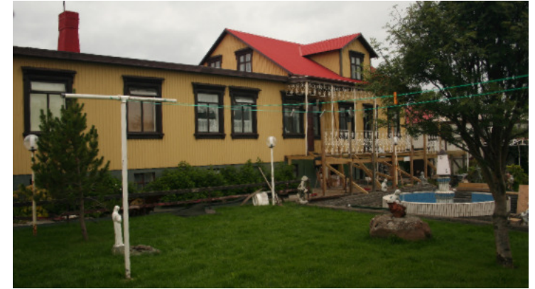
Núverandi ástand húss - Austurhlíð að garði / Læknishúsið t.h.
