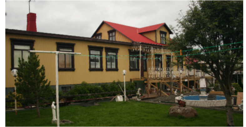
Núverandi ástand húss - Austurhlíð að garði / Læknishúsið t.h.
