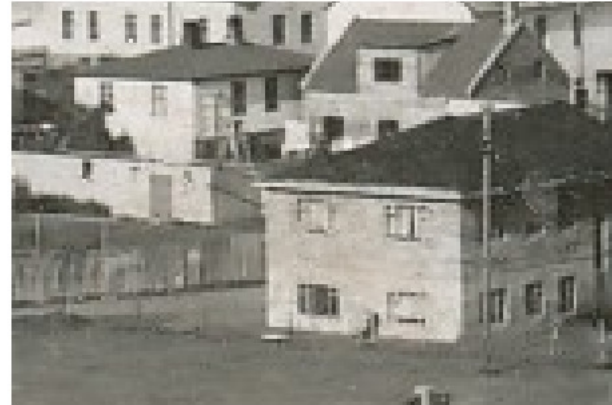
Bakhúsið þ.e. Aðalgata 3B er risin - Fremst er Hreppshúsið
