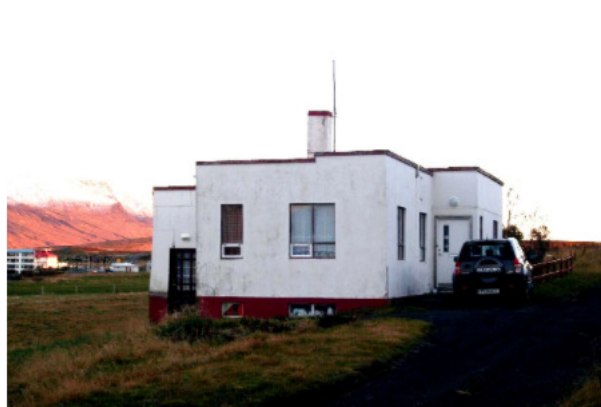
Mynd frá 2015 - Aðkoma og inngangar
