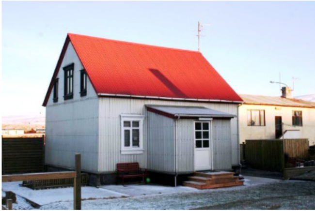
Mynd frá 2010 - Útlit að garði og Hnjúkabyggð hér er komið nýtt bíslag (inngangur)
