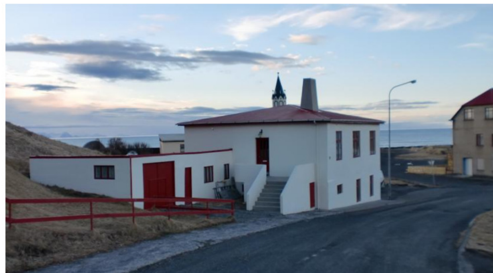
Horft til norðurs - Aðalinngangur - T.h. á mynd er Aðalgata 8
