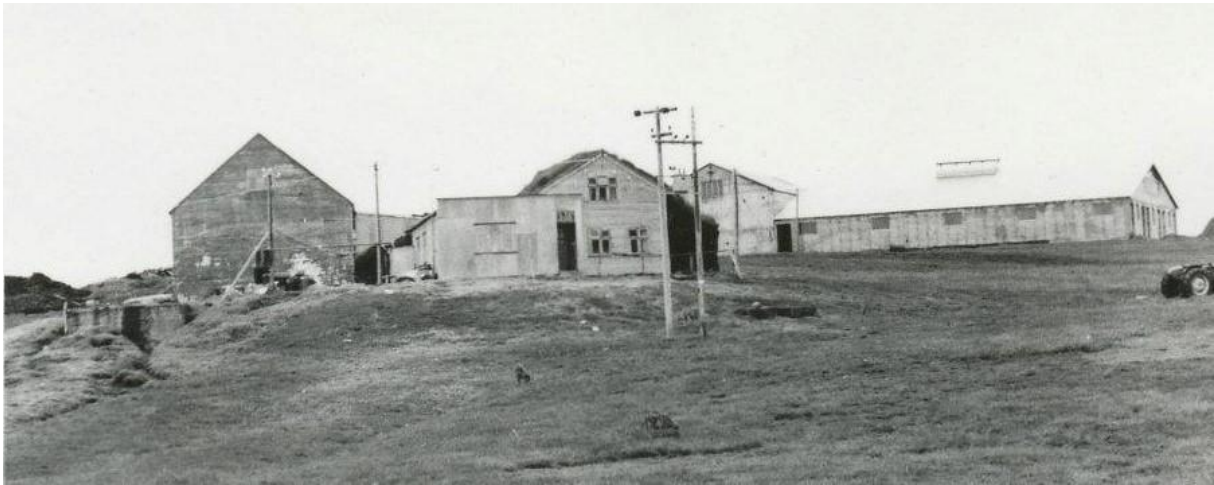
Enni um 1975. Lengst til vinstri er steinsteypta heyhlaðan frá 1929 og gamli torf- og timburbærinn fyrir miðju ásamt viðbyggingu frá 1939, en til hægri eru steinsteypt heyhlaða og fjárhús frá 1954 og 1955. (Ljósmyndasafn A-Hún.)
