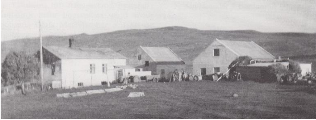
Bæjar- og útihús á Neðri-Mýrum um 1960. Til vinstri er íbúðarhúsið og norðan við það steinsteypt fjóshlaða, sem nú er horfin, en austar er steinsteypt véla- og verkfæragæymsla frá 1957. (Ættir Austur-Húnavetninga II, s. 628.)
