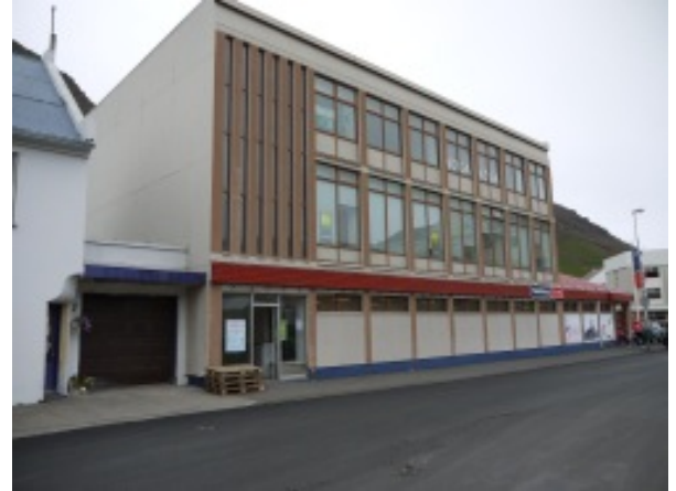
2011 Suðurgata 2 t.h. er áföst Suðurgötu 4
