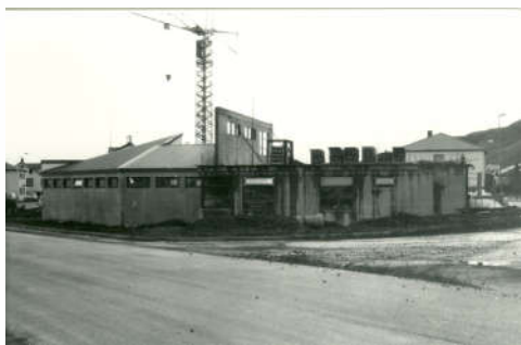
Suðurgata 1 í byggingu. Mynd úr safni HSK.
