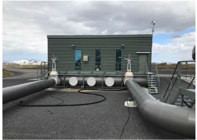
Niðurrennslishús. Ásýnd úr suðri, 2020.
