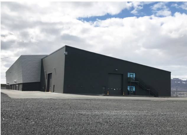
Stöðvarhús, horft úr norðri 2020.
