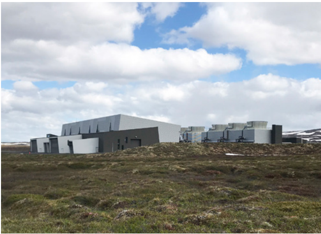
Stöðvarhús og kæliturnar, 2020.
