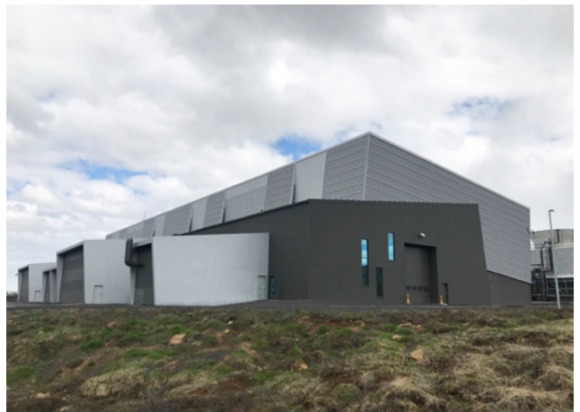
Stöðvarhús, horft úr suðvestri.
