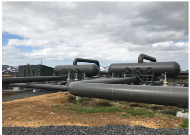
Skiljuskýli og niðurrennslishús, 2020.
