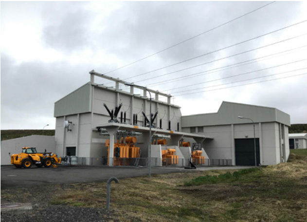
Steypar stoðir rísa upp úr tengivirkisálmum stjórnhússins og frá þeim liggja háspennulínur, 2020.
