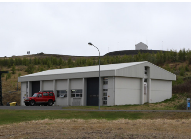
Horft yfir verkstæðishús frá stjórnhúsi. Inntakshús í bakgrunni, 2020.
