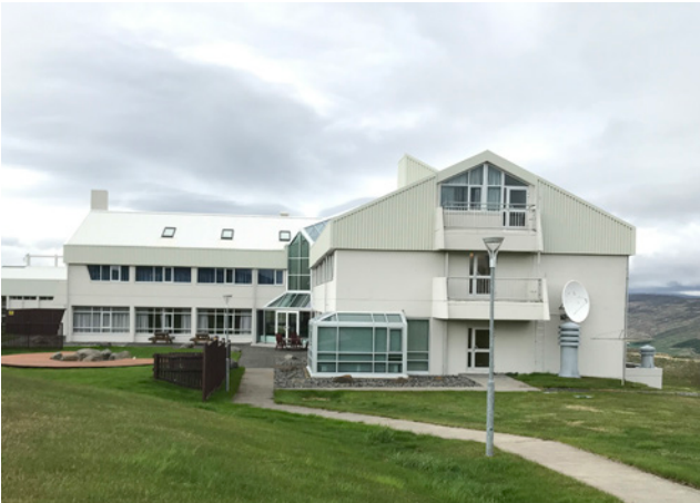
Starfsmannahús, horft úr suðri, 2020.
