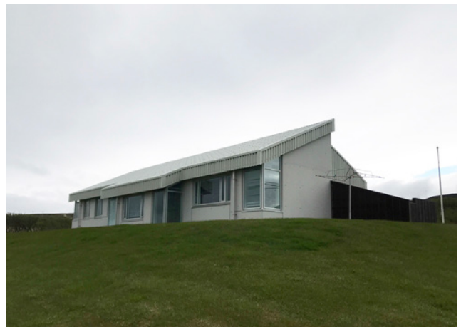
Starfsmannahús, horft úr norðaustri, 2020.
