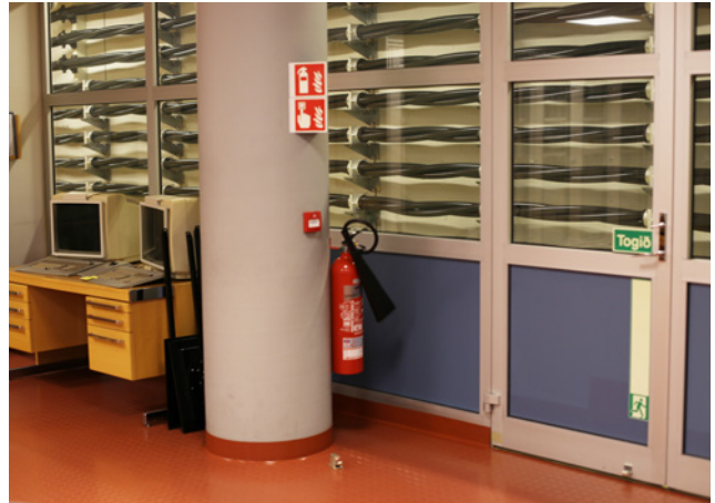
Innan úr stöðvarhúsi, 2020.
