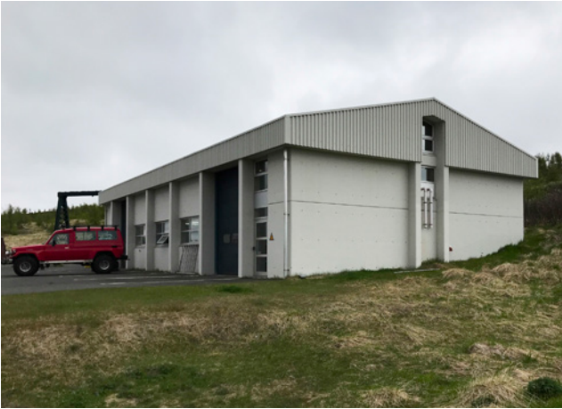
Verkstæðishús, horft úr suðri, 2020.
