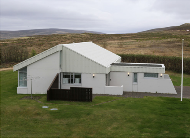
Starfsmannahús, horft úr norðri, 2020.
