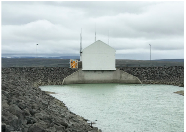
Inntakshús, horft úr vestri, 2020.
