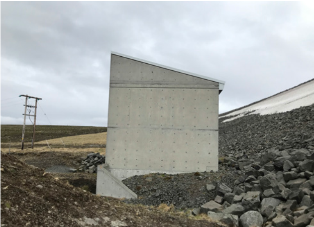
Lokuhús, horft úr vestri, 2020.
