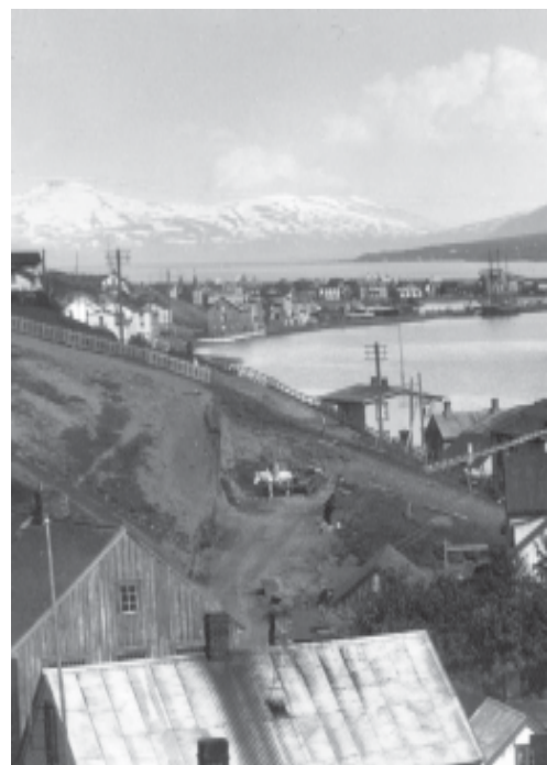
25. ramkvæmdir við lagningu Spítalavegar um 1927.
