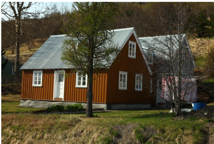
Viðbygginguna við Aðalstræti 44 teiknaði Finnur Birgisson arkitekt árið 1994. Gamla húsið er í forgrunni en viðbyggingin í bakgrunni.
