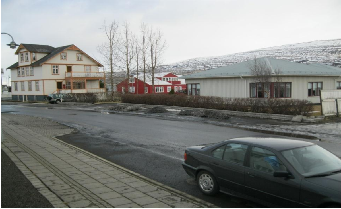
Húsið lengst til hægri er Hafnarstræti 16, byggt 1994. Hér er ekki gerð nein tilraun til aðlögunar að umhverfinu eða nærliggjandi húsum, hvorki í stíl eða kvarða.
