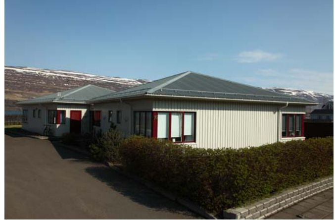
Hafnarstræti 16, norðurhlið árið 2011.
