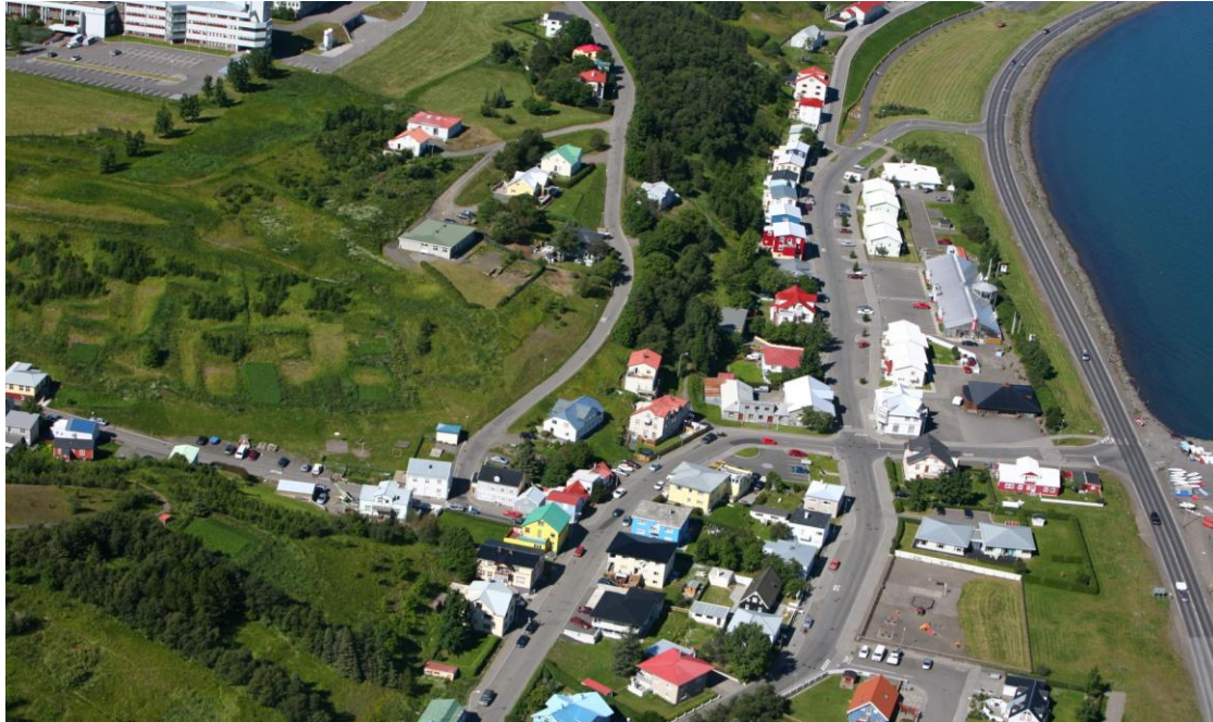
Loftmynd frá 2009. Á henni sést vel hve byggðin á kjarnasvæðinu við austanvert Hafnarstrætið er sundurleit.
