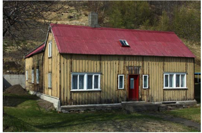
Aðalstræti 32 árið 2011. Unnið er að endurbyggingur hússins .
