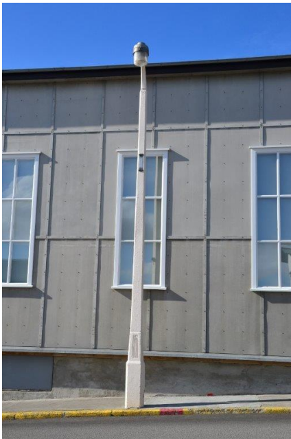
Mynd 22. Ljósastaur við Skaldborg.
