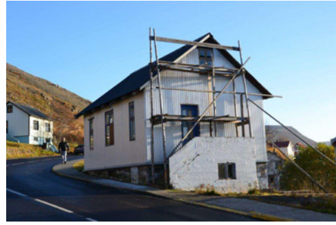
Dallahús 2017, unnið að uppgerð.
