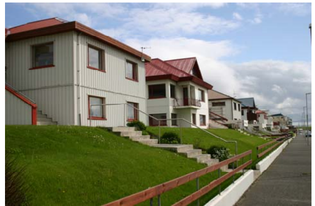
Við Jaðarsbraut og fleiri götur norðaustarlega á skráningarsvæðinu standa fúnkishús, sem ýmist eru tvílyft eða ein hæð á háum kjallara.
