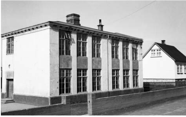
Gamli iðnskólinn við Skólabraut byggður 1912. Ljós. Ólafur Árnason. Ljósmyndasafn Akraness.
