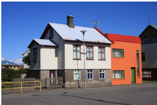
Akratorg. Skólabraut 35 og 35A. Varðveislugildi beggja húsa 2.
