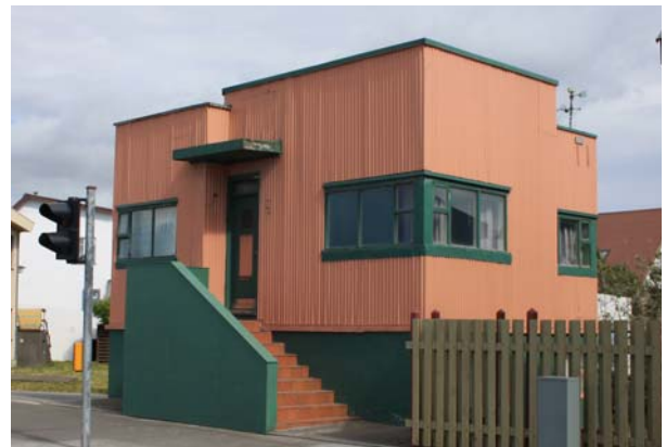
Kirkjubraut 32, byggt 1934, bárujárnsklæddur timburfúnkis með skúrþaki sem hallar að bakhlið hússins.
