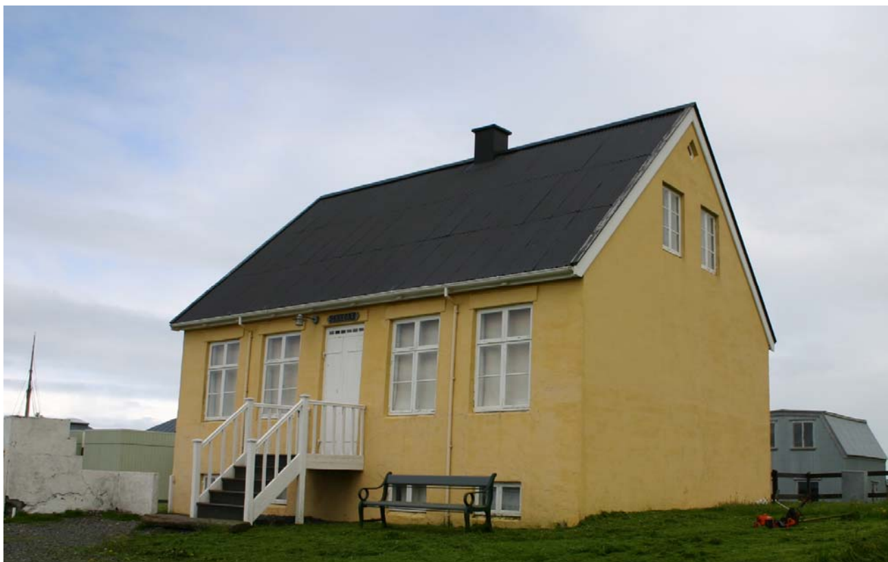
Garðar voru hlaðnir úr steinsteyptum steinum á árunum 1876-1882 af Sigurði Hanssyni steinsmið.
