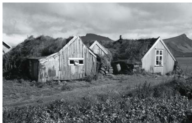
Síðasti torfbærinn á Akranesi var Teigakot sem stóð á Akurshól. Ljós. óþekktur. Ljósmyndasafn Akraness.
