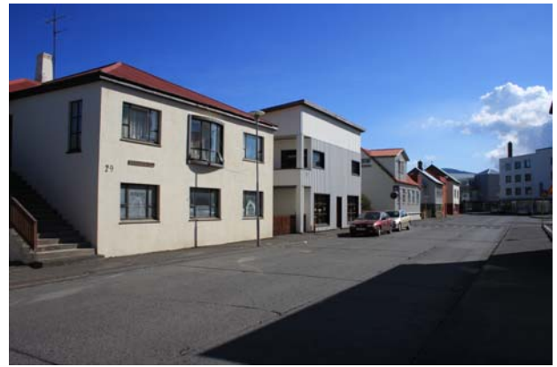
Á Neðri- Skaga eru húsini fjölbreytileg að gerð og byggingarefni og standa mörg hver frammi við götu og mynda þétta byggð.
