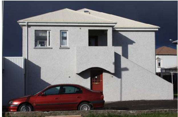
Suðurgata 62 B, hefur nýlega verið endursteynað.
