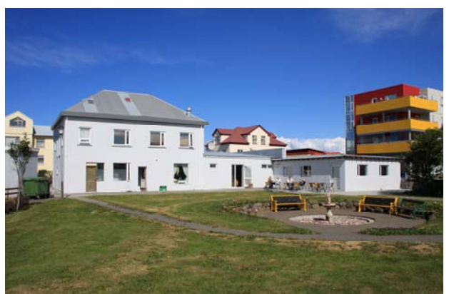
Kirkjubraut 8 t.v. varðveislugildið 2 og fyrir nr. 10 er varðveislugildið 3, séð frá Skrúðgarðinum.
