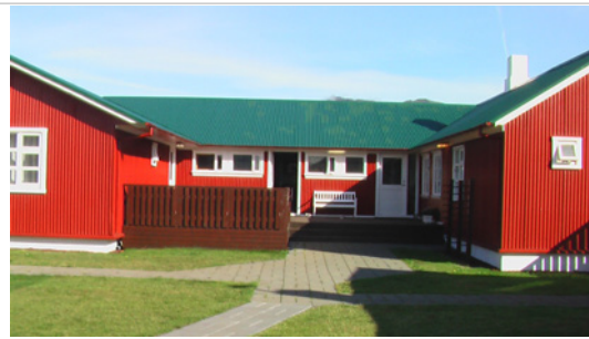
Tengibygging / inngangur frá 1986
