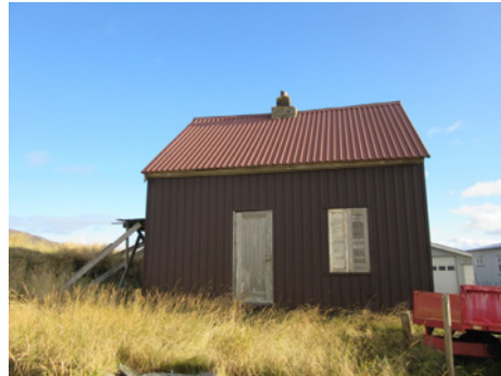
Einland 2017, horft til norðausturs
