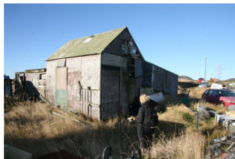
Húsið 2017, horft til NNV
