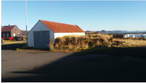
Hús 15: 2017, horft til austurs
