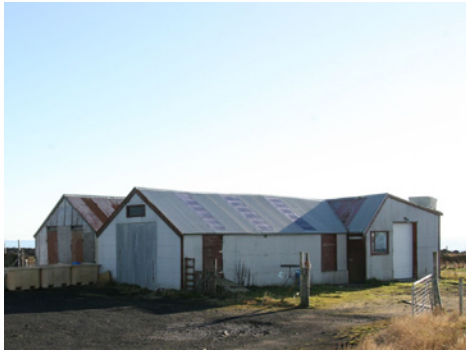
Hús 5, horft til suðurs
