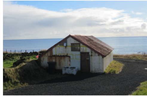
Hús 11 2017, horft til suðurs
