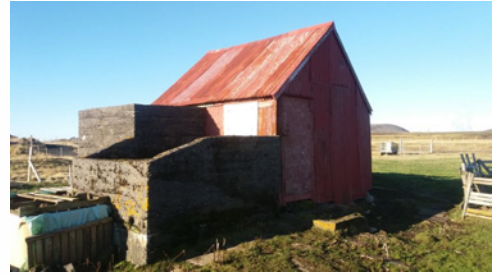
Hús 23 horft til NNV
