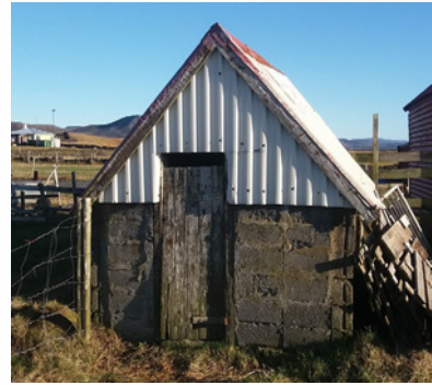
Hús 14 2017, horft til austurs
