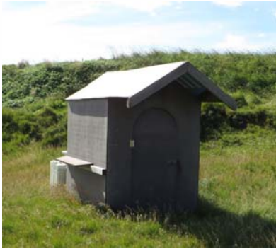
Hús 31 dúkkukofi, 2017 horft til suðvesturs
