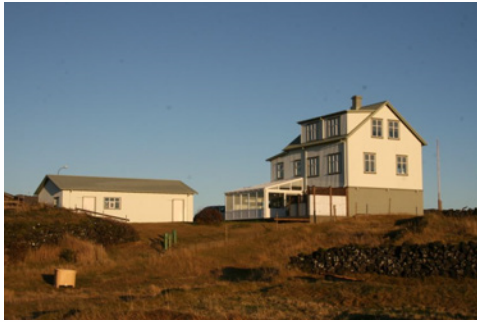
Bílskúr og íbúðarhús 2017, horft til NNV
