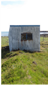
Hús 01: dæluhús 2017, horft til suðurs
