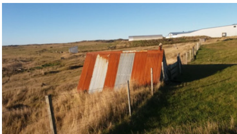
Hús 4: Reykkofi, horft til vesturs
