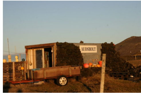
Geymsluskúr við Auðsholt 2017, horft til NNV
