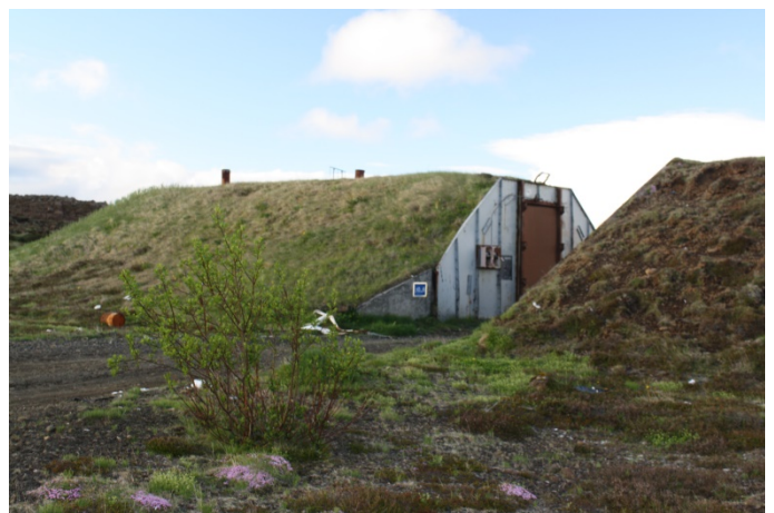
Sprengjugeymsla 2026 haustið 2019. Þessi geymsla er ein af upphaflegri gerð og enn með stálframhlið. Á mörgum öðrum er búið að steypa upp framhliðina. Mynd: Helgi Biering.
