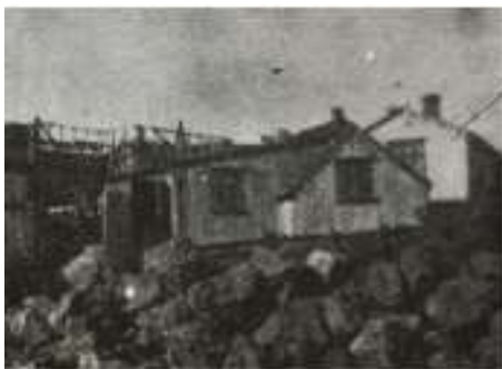
Húsið við Kirkjuveg. Byggðasafn Hafnarfj.
