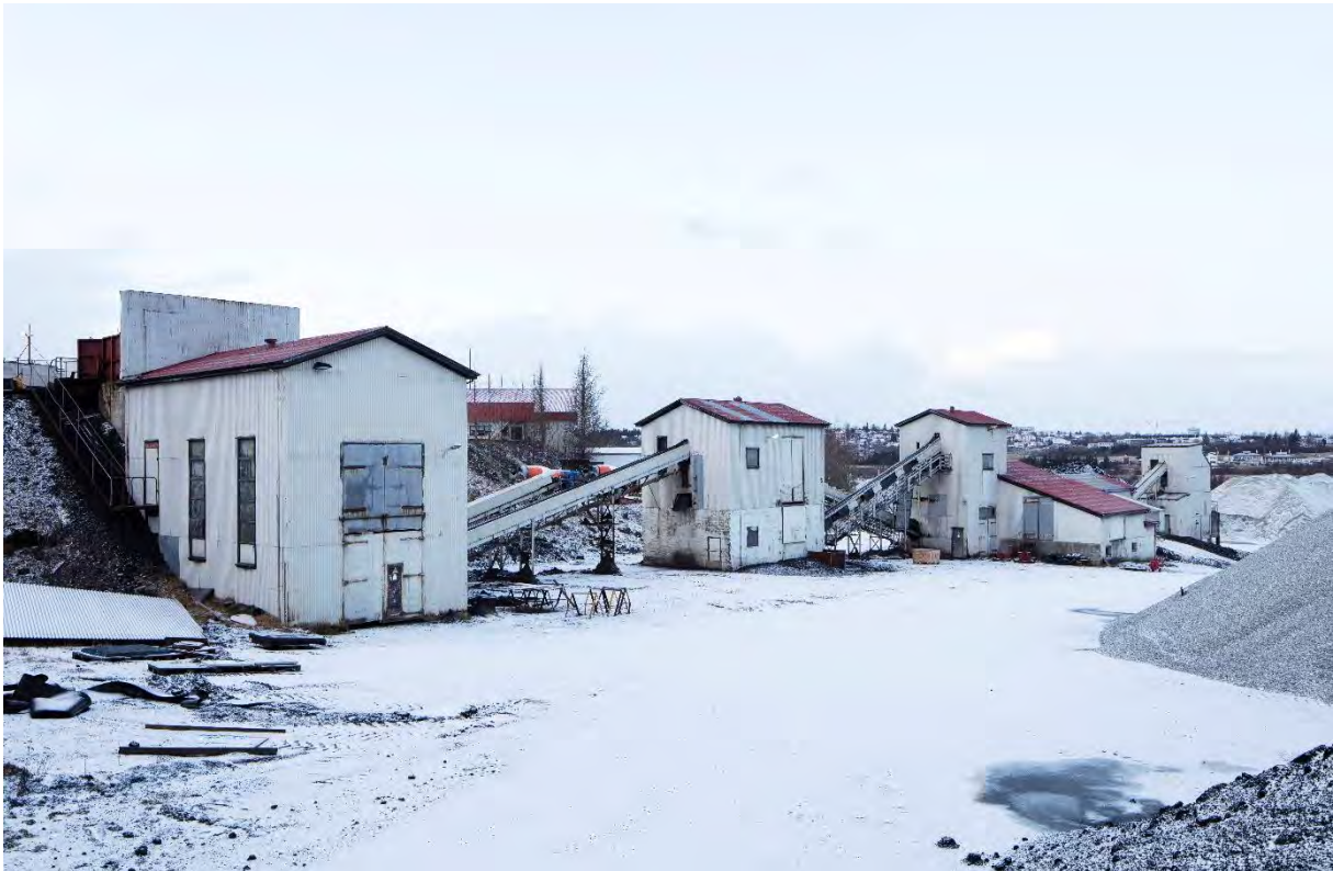
Mynd 19. „Nýja grjótmulningsstöðin“ árið 2019. 54
